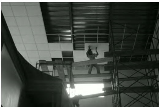
Construcción por zonas en alturas.
