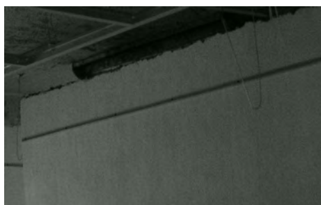
Vista de ángulo perimetral instalado.
