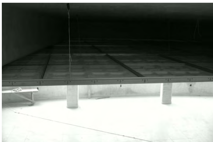
Vista interna de la cámara plena, con el sistema completo de fijación a losa, colganteo y suspensión Quick Lock ®.
