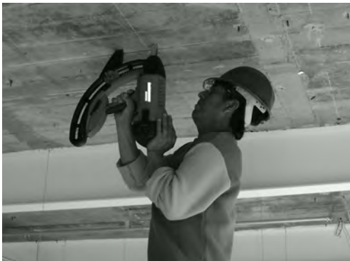
Taqueteo con pistola de gas a presión, con equipo de seguridad.
