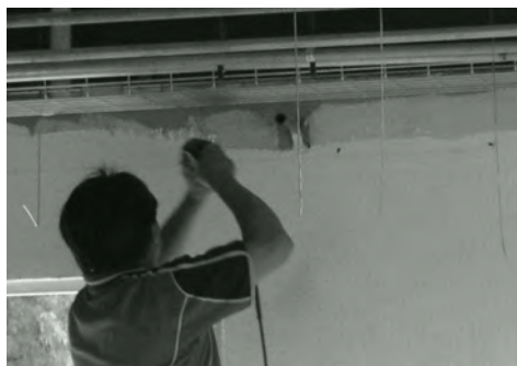
Barrenos para fijación de ángulo perimetral.
