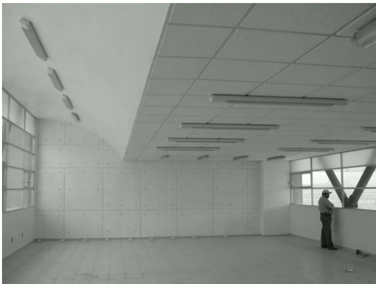
Vista de plafón terminado.
