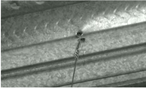
Colgante de alambre en sistema Losacero.
