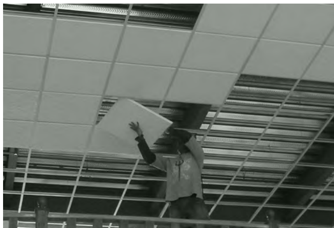
Instalación de placa entera.
