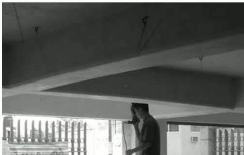
Perforación de barrenos con taladro.
