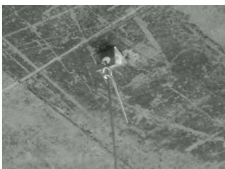
Fijación con pistola a gas comprimido, incluye clavo para concreto o acero y escuadra.
