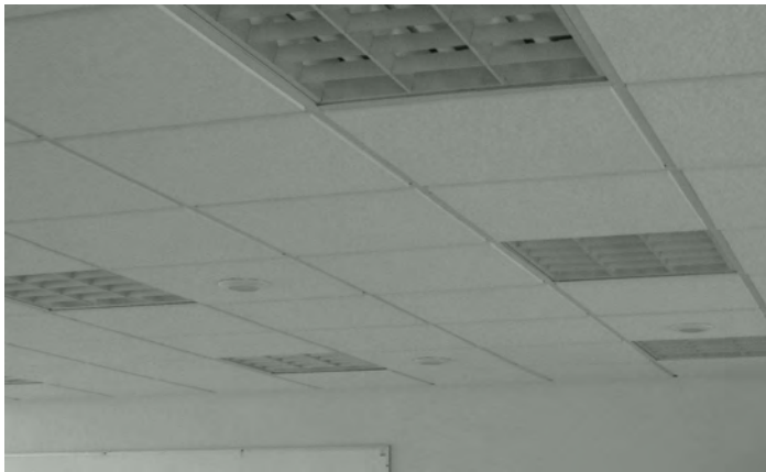
Tipos de luminarias de empotrar: modulares y spots.
