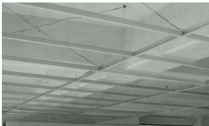
Instalación de Contravientos para alinear la suspensión. (Nótese que el contraviento se coloca en la unión de un larguero con un separador de 122cm).
